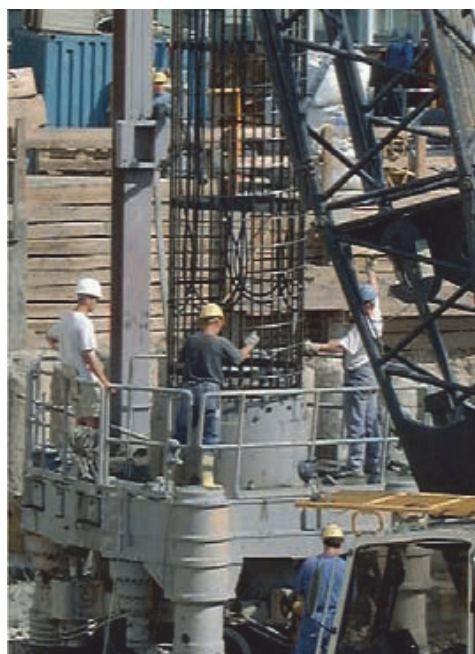
Figure 6-38. Tour Galileo à Francfort. Mise en place de la cage d'armature d'un pieu de fondation. Les tubes échangeurs sont visibles à l'intérieur de la cage
