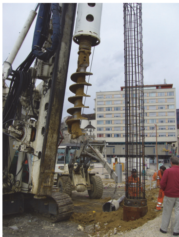
Figure 6-17. Pieu énergétique en cours d'exécution à Delémont (photo Compatible SA).
