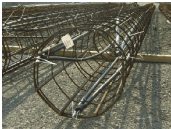
Figures 6-18 et 6-19. Halle CICR à Satigny. Cages d'armatures de 20 m équipées des sondes en double-U en attente (photo Haka Gerodur)
