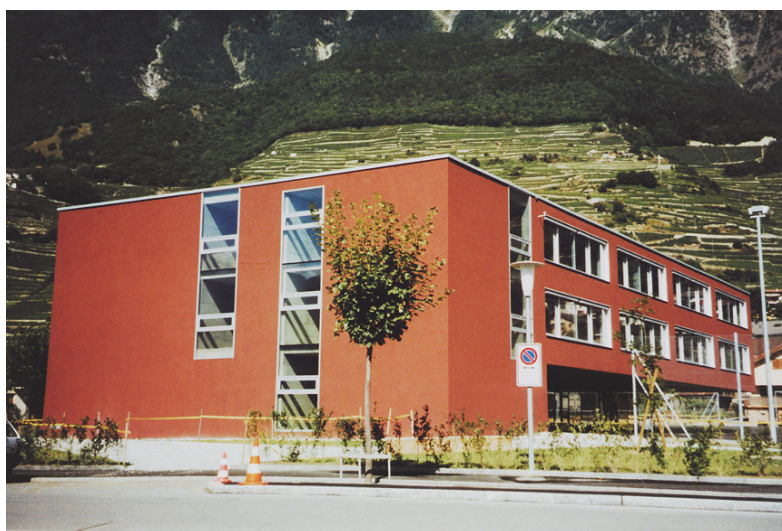
Figure 6-12 . Vue du nouveau bâtiment scolaire de Fully, en Valais, équipé de 41 pieux énergétiques (photo J. Wilhelm).
