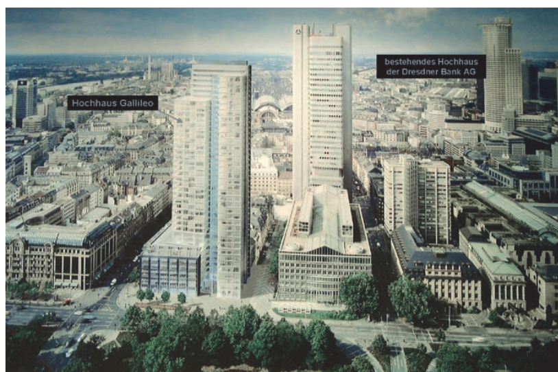
Figure 6-37. Bâtiments tours sur pieux énergétiques dans le centre de Francfort sur le Main, en Allemagne
