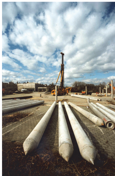
Figure 6-3. Pieux centrifugés avant mise en place (photo GRAM SA)
