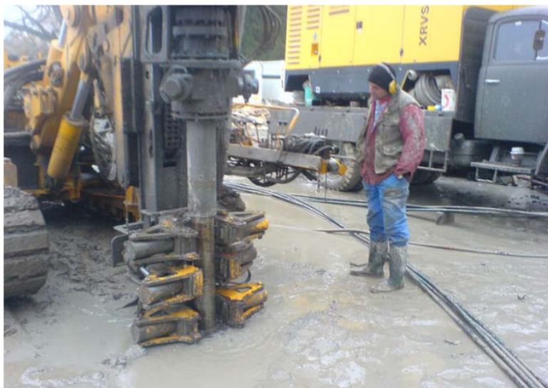
Figure 4: Difficultés d'avancement et limitation technique de la profondeur de forage en raison des caractéristiques des terrains rencontrés (limons très fins saturés en eau).
