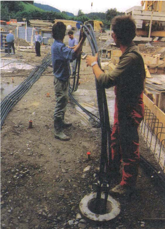
Figure 2.2.6 : Pose de la conduite de circulation du fluide caloporteur dans la cavité intérieure d'un pieu battu dans le sol (photo SACAC AG, Lenzburg).
