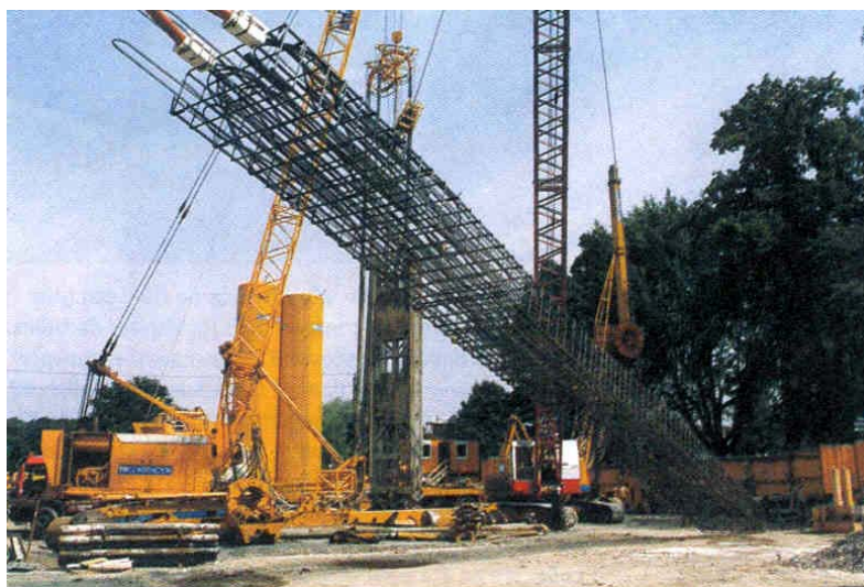
Figure 2.2.5 : Mise en place de la cage d'armature d'une paroi moulée équipée de conduites de circulation de fluide caloporteur (photo Nägelebau, Rötthis).
