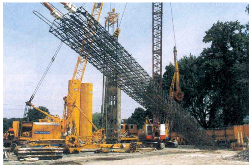
Figure 2.2.5 : Mise en place de la cage d'armature d'une paroi moulée équipée de conduites de circulation de fluide caloporteur (photo Nägelebau, Röthis).
