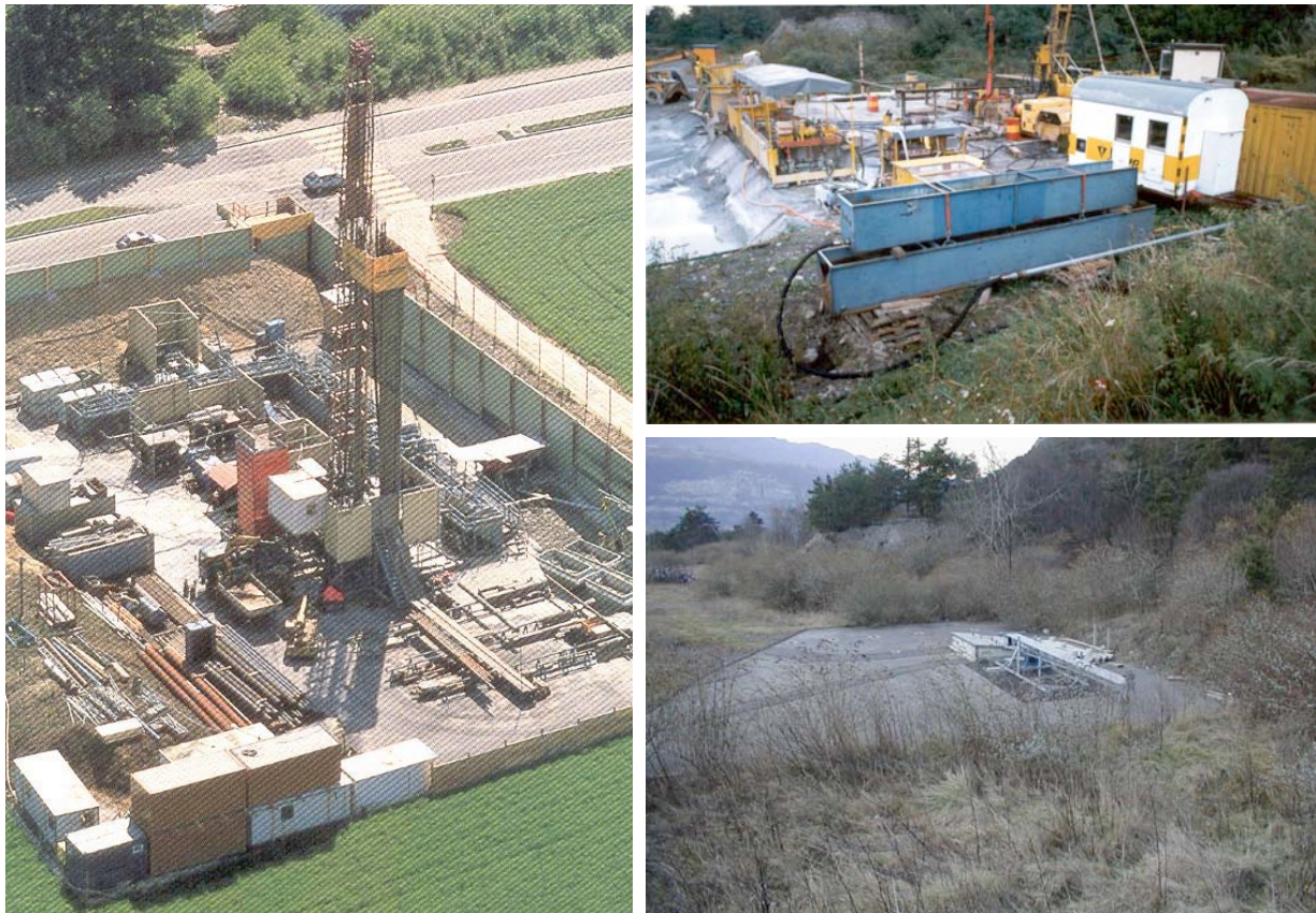
Figure 3.3.1 : Exemples de chantiers de forages géothermiques. A gauche, celui du forage de Reinach (profondeur 1'793 m), muni d'une protection phonique. A droite, le chantier du forage P600 de Lavey-les-Bains, situé en pleine nature. La photo du bas montre l'emprise au sol du puits géothermique en exploitation. Outre la cave de forage et le radier asphalté, un treuil pour ressortir la pompe immergée a été laissée sur place (sources : Weber 1990 et Bianchetti 2002).
