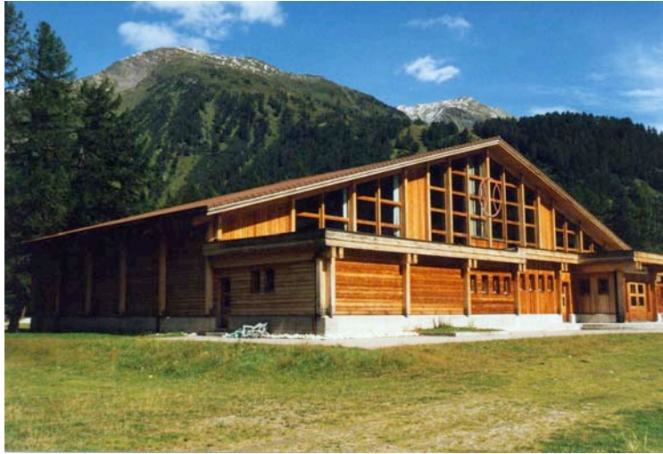
Figure 7 : Salle multisport d'Oberwald chauffée par le tunnel de la Furka (photo J. Wilhelm)
