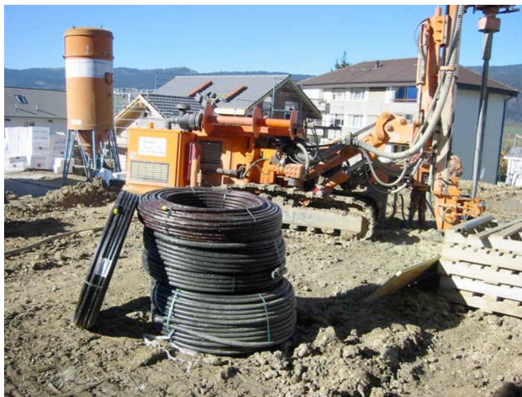
Figure 2 : Forage d'une sonde géothermique verticale pour une villa (photo S. Cattin)
