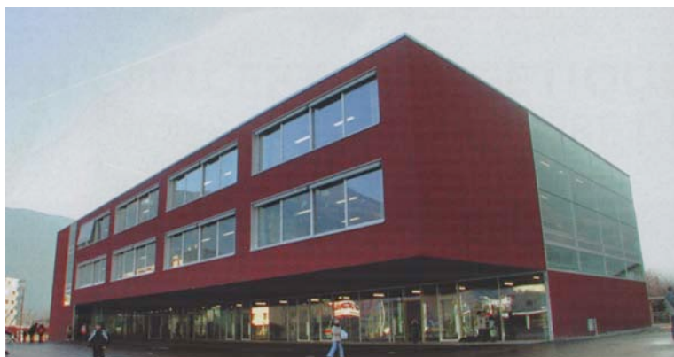
Figure 3 : Bâtiment scolaire Minergie à Fully chauffé et refroidit par des pieux énergétiques (photo E. de Lainsecq)
