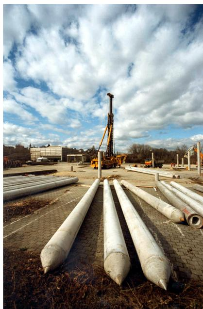
Figure 3.2. Pieux centrifugés déposés sur le chantier avant mise en place (photo GRAM SA).
