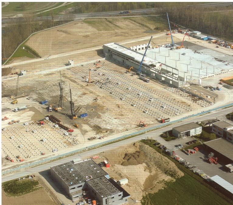
*Figure 3.14. Vue du chantier Aldi à Domdidier, avec au centre les rangées de pieux énergétiques (photo Aldi).*
