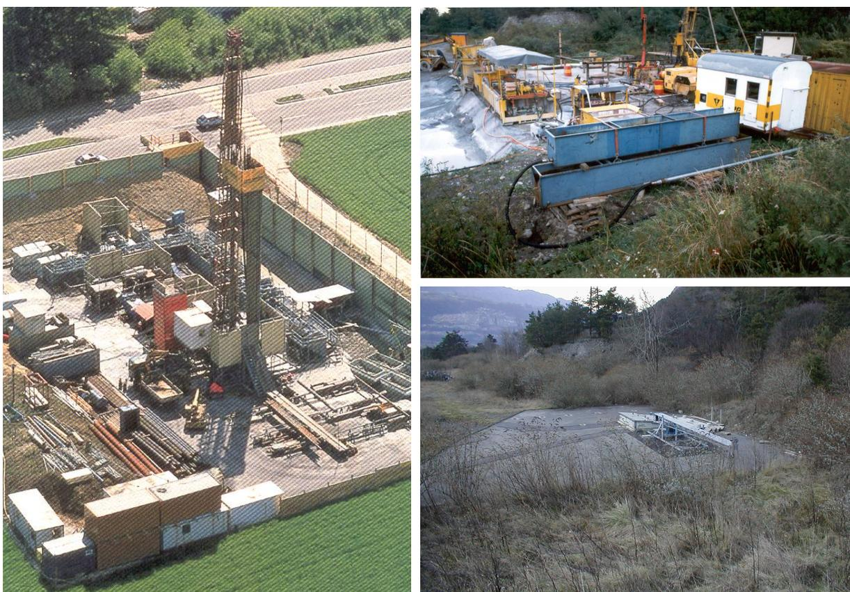
Figure 5.2. Exemples de chantiers de forages géothermiques. A gauche, celui du forage de Reinach (profondeur 1793 m), muni d'une protection phonique. A droite, le chantier du forage P600 de Lavey-les-Bains, situé en pleine nature. La photo du bas montre l'emprise au sol du puits géothermique en exploitation. Outre la cave de forage et le radier asphalté, un treuil pour ressortir la pompe immergée a été laissé sur place (Weber, 1990 et Bianchetti, 2002).
