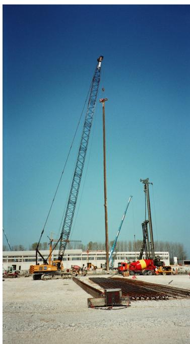
*Figure 3.15. Pose d'un pieu énergétique de 38 mètres de long sur le chantier Aldi à Domdidier (photo J. Wilhelm).*
