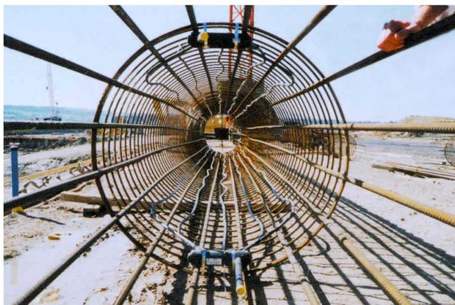
Figure 3.4. Conduites de circulation de fluide caloporteur fixées à la cage d'armature d'un pieu moulé (photo F-D. Vuataz).
