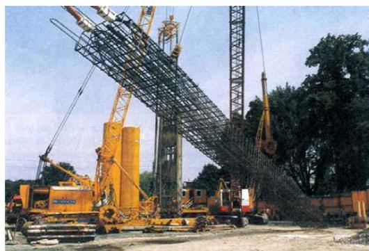
Figure 3.5. Mise en place de la cage d'armature d'une paroi moulée, avec les conduites de circulation de fluide caloporteur (photo Nägelebau).
