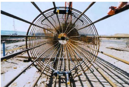
Figure 3.4. Conduites de circulation de fluide caloporteur fixées à la cage d'armature d'un pieu moulé (photo Vuataz, CREGE).
