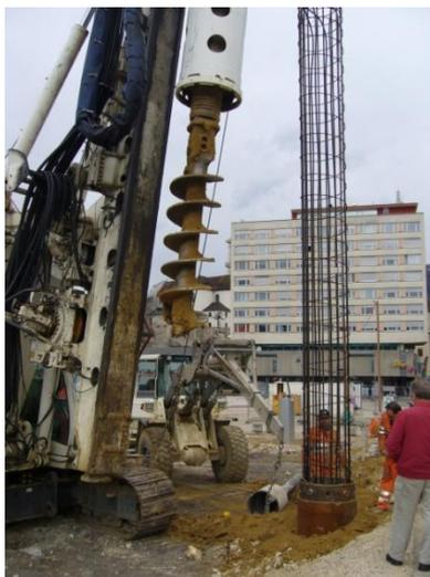
Figure 3.10. Pieu énergétique en cours d'exécution à Delémont (photo Compatible SA).
